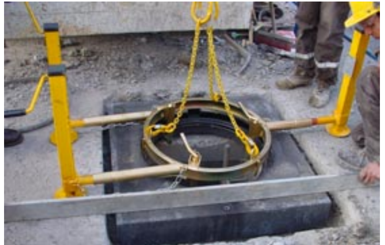
4-Faire un pré-réglage de niveau avant scellement
