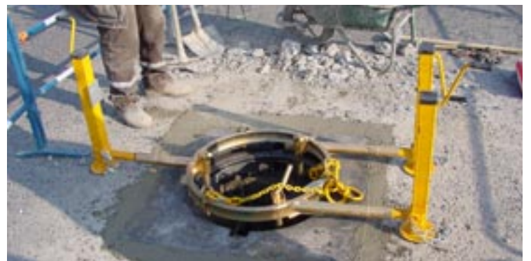
6-Maintenez à niveau durant le séchage
