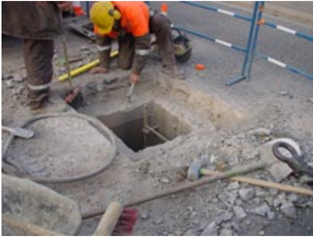
1-Décaisser la chaussée
