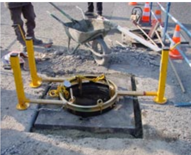
5-Sceller et affiner le parfait niveau de la chaussée grâce aux 3 béquilles indépendantes
