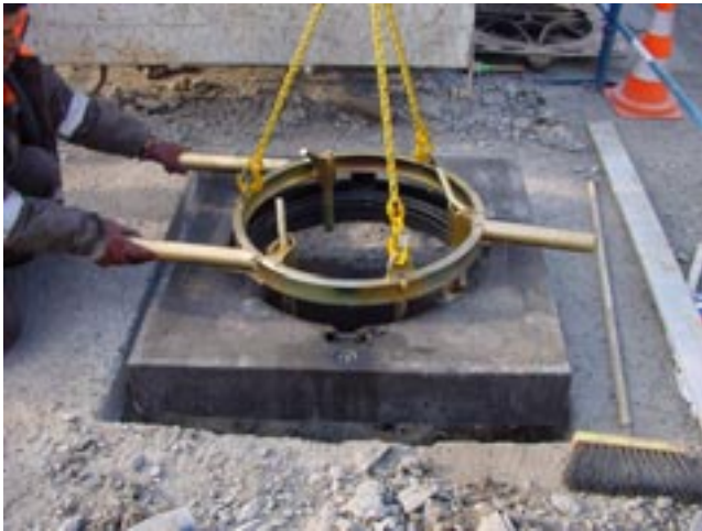
3-Contrôler le volume du décaissement
