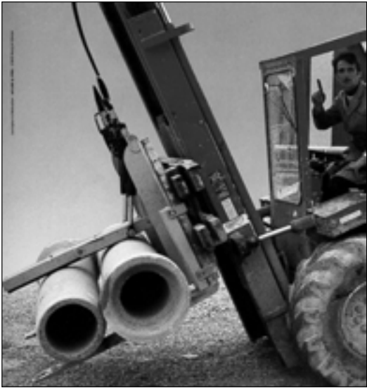
Maintien de tuyaux béton
