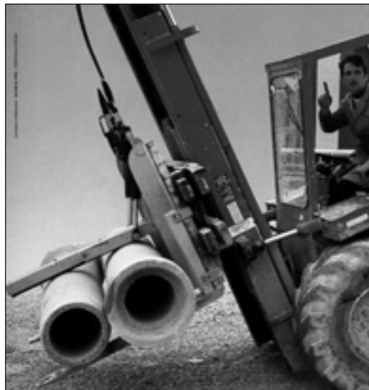
Maintien de tuyaux béton
