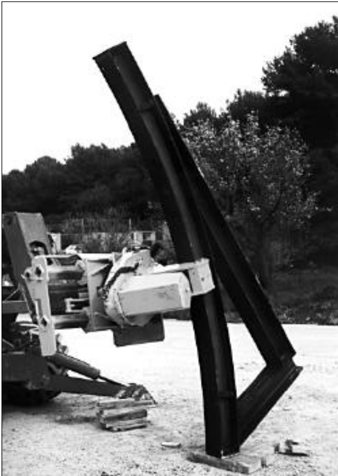
Prise, manutention et mise en place précises d'un pied latéral.
