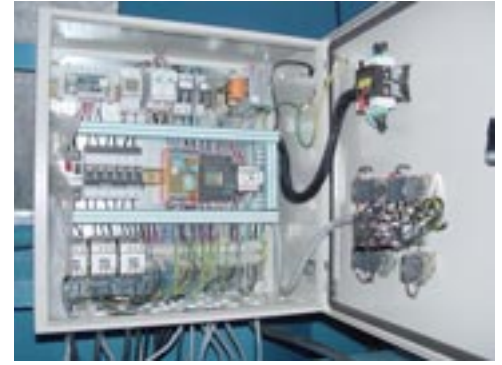
Gestion par automate à console de réglage intégrée. Compteur de cycle.
