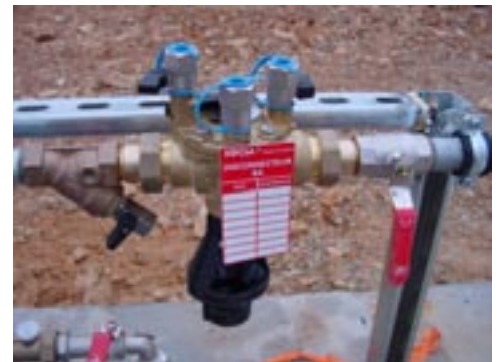
Prévoyez un disconnecteur de protection
