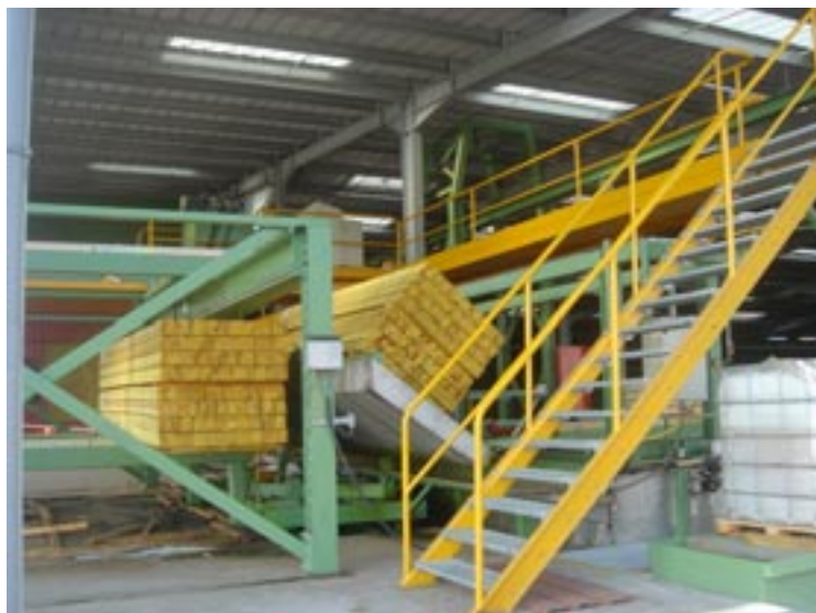
Une charge en égouttage, la précédente sur le convoyeur de sortie
