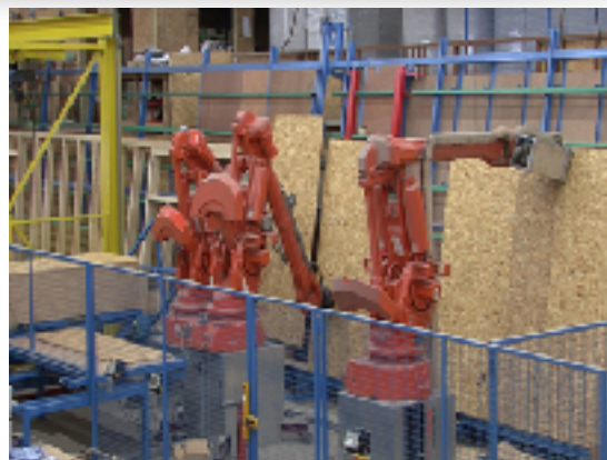
Ligne de production de murs
